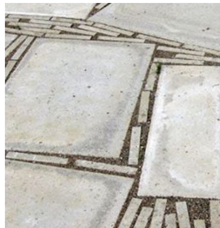
Reference belægning (ref. Schönherr).
