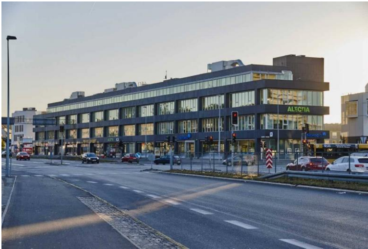
Viby Torv, betonkonstruktioner er malet efter betonreparationer
