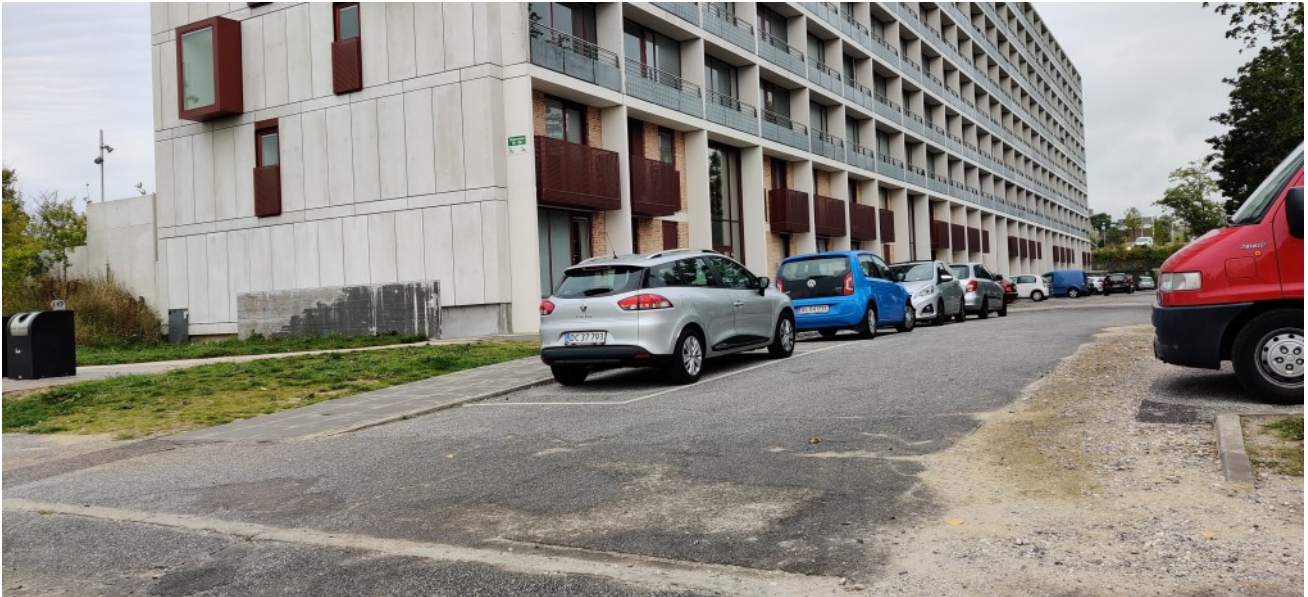
Billede af den renoverede blok B7 med altaner og store vinduespartier i alle lejligheder. Bebyggelsen har, med Gellerupparkens andre storskalablokke, en vigtig kulturhistorisk værdi.
