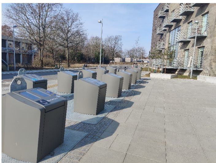
Foto: Nedgravede affaldscontainere ved Aarhus Kollegiet
